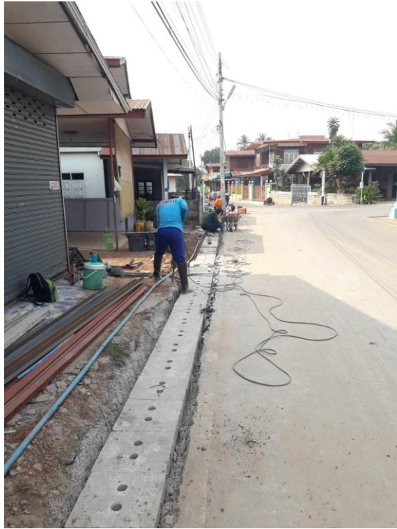
โครงการก่อสร้างวางระบายน้ำ ค.ส.ล. รูปตัว หน้าบ้าน นายฤกษ์กรณ์ สอนพงษ์ (ต่อโครงการเดิม) ภายในหมู่บ้าน บ้านสร้างหลวง หมู่ที่ ๔ ตำบลบ้านเตือ อำเภอกำแพง จังหวัดหนองคาย
